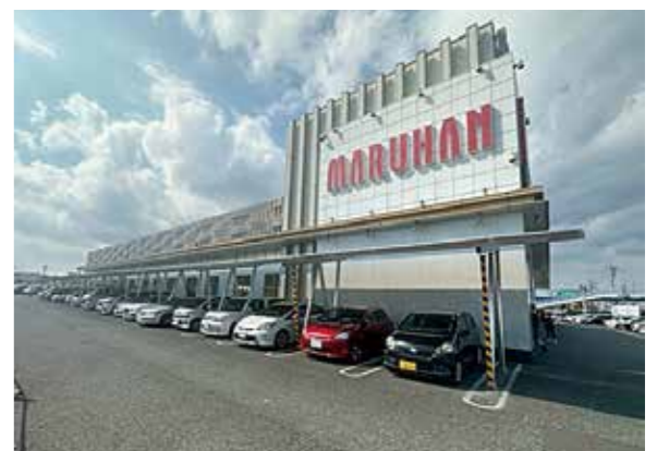
ソーラーカーポートも導入したマルハン入間店
